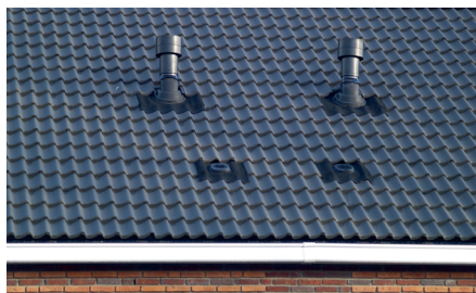
In het dak
