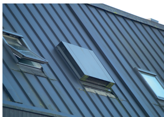
In het dak
